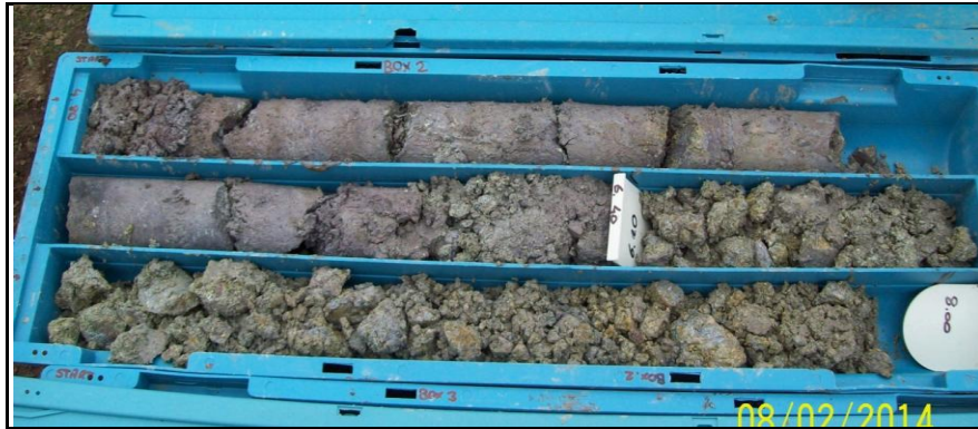
Yüksek seviyede altere olmuş halde gözlenen andezit
